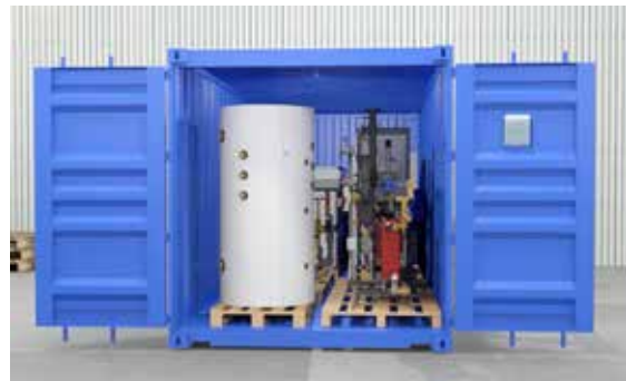
Containern från HögforsGST innehåller allt som behövs för installationen, skräddarsytt för den enskilda fastigheten.
